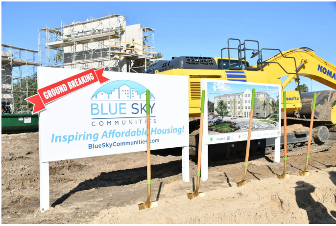
Groundbreaking at Casa de Francesco.
